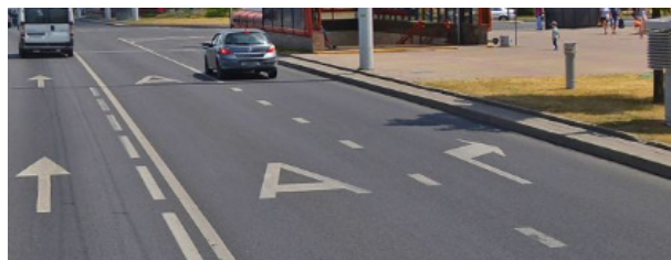
Рисунок 3. Смещение выделенной полосы с организацией кармана для правоповоротных транспортных средств
